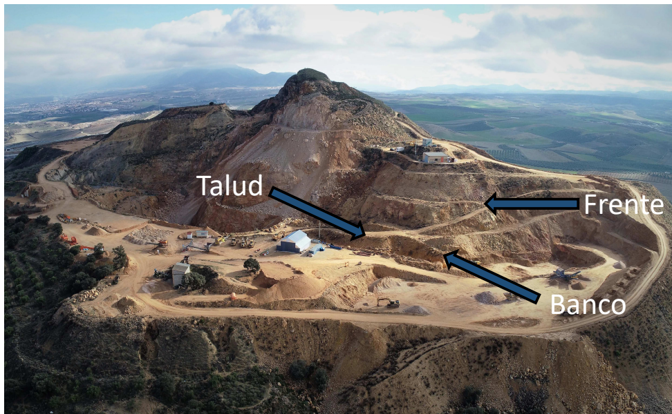
Fig. 6. Explotación a cielo abierto. Elementos principales (banco-frente-talud).
