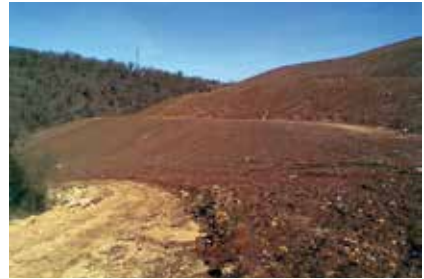
Figura 50. Estado de la escombrera (2008).
