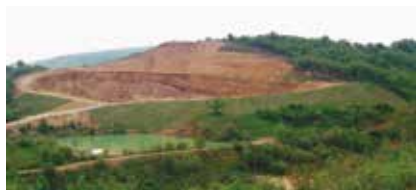
Figura 67. Frente sureste, en restauración (mayo de 2008).
