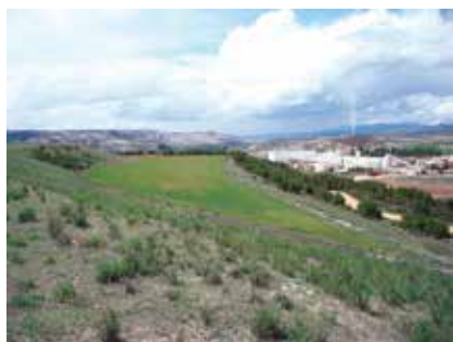
Figura 57. Detalles de los taludes restaurados.
