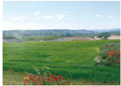
Figura 55. Vista general de los taludes restaurados.
