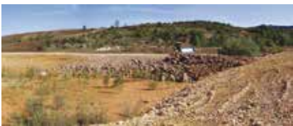
Figura 83. Preparación del humedal (2011).
