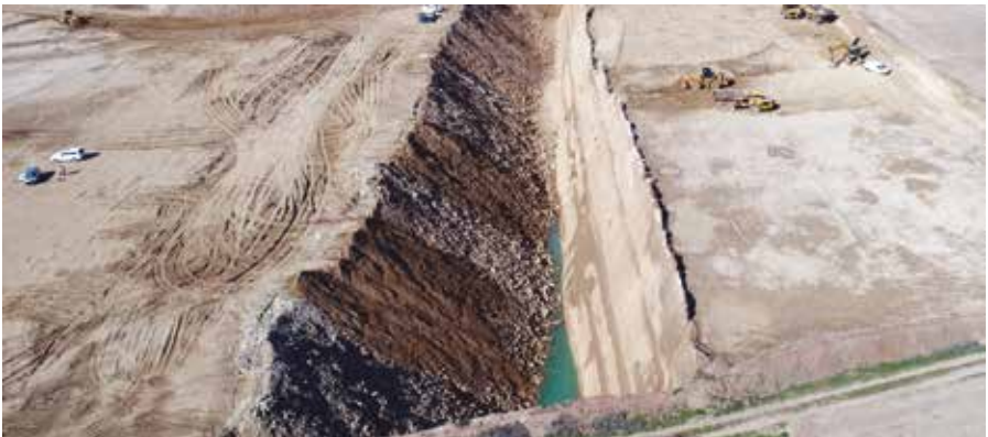
Figura 91. Avance de la restauración.
