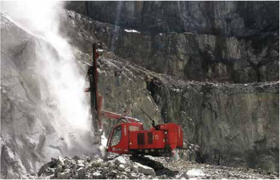
Figura 35. Perforación. Fuente: MOVITEX, S.L.
