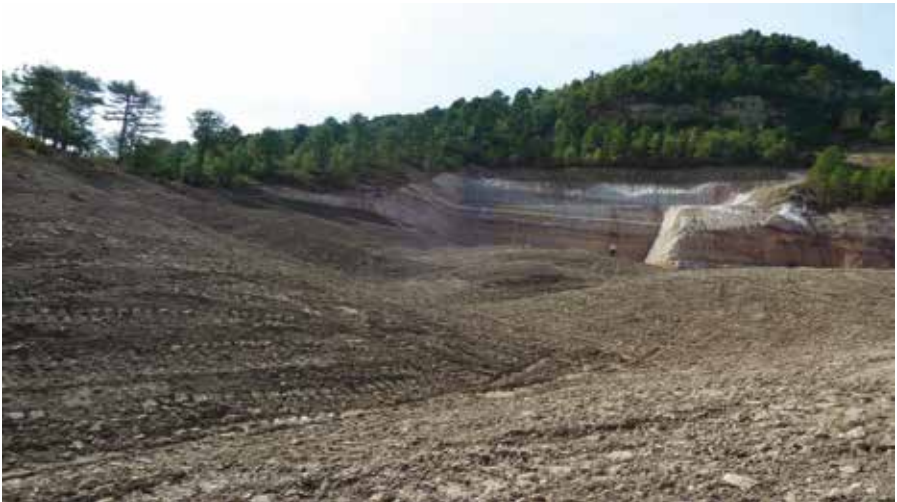
Figura 53. Restauración geomorfológica previa a la fase revegetativa en la explotación Machorro (CAOBAR, S.A.).
