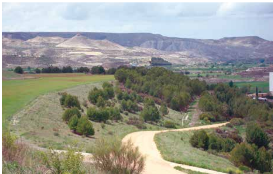
Figura 58. Detalles de los taludes restaurados.
